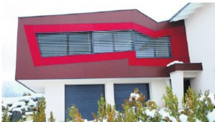
Zubau mit mehrfach geknicktem Dach.
